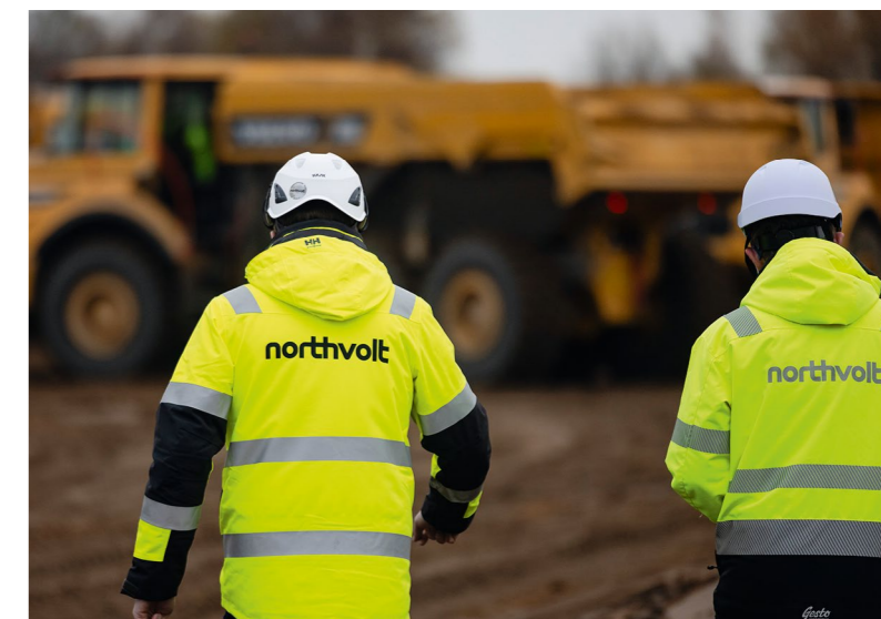
Auf dieser Baustelle in Heide im Kreis Dithmarschen soll die staatlich geförderte Northvolt-Batteriefabrik entstehen.
